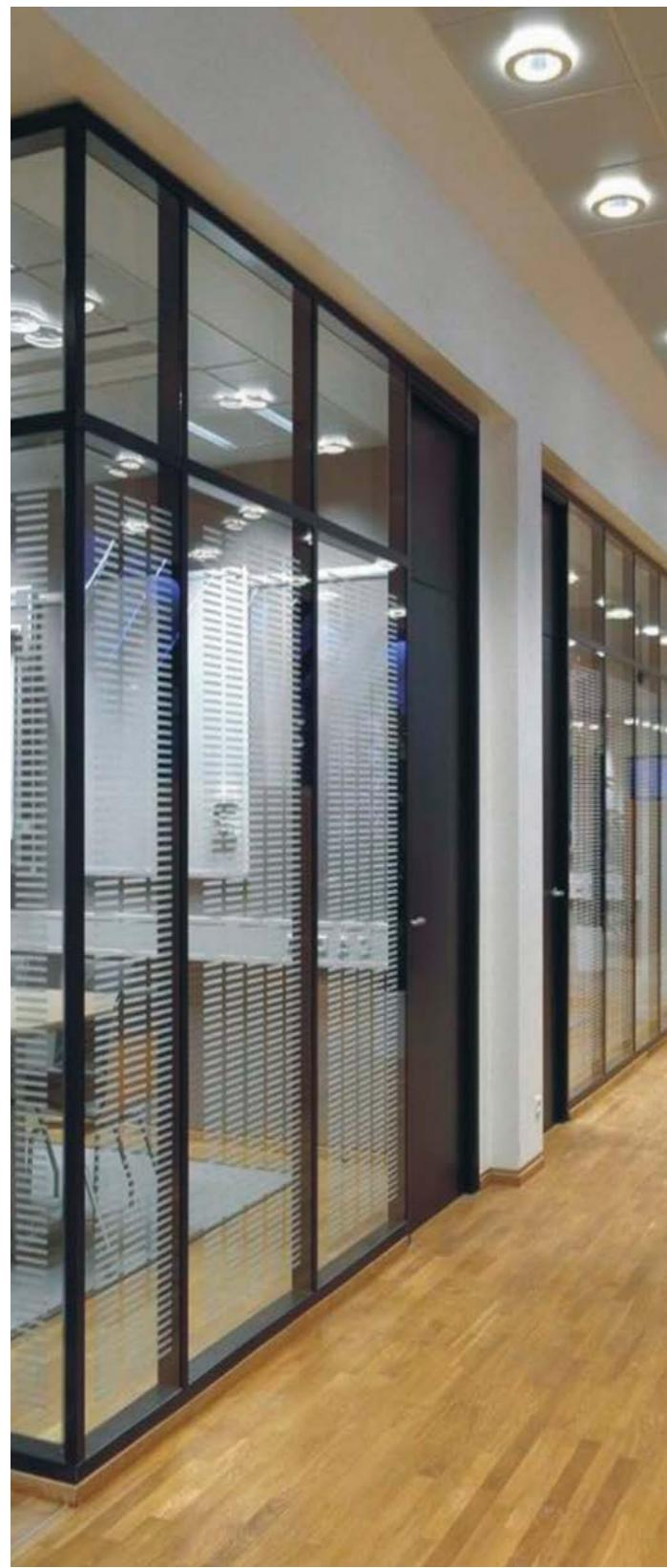
Светопрозрачные алюминиевые конструкции изготавливаются из легкого, но прочного алюминиевого каркаса, в который могут встраиваться, в зависимости от пожеланий заказчика: витражи, стеклопакеты, окна и двери, из алюминиевого профиля или ПВХ. Все элементы изготавливаются из энергосберегающего и солнцезащитного стекла, произведенного на основе нанотехнологий.
