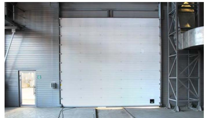
**Секционные ворота** – въездная конструкция, состоящая из соединенных петлями секций, которые при открывании планомерно и бесшумно уходят вверх по направляющим шинам. В сравнении с другими разновидностями этот тип ворот наиболее устойчив к несанкционированному проникновению за счет высоких технических характеристик. Такие ворота наиболее популярны для обустройства въезда в гаражи и производственные помещения.
