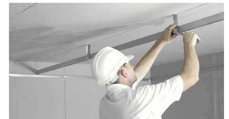
Финишированные мастера произведут все необходимые замеры, проведут монтаж металлического профиля и установку гипсокартонных листов. По требованию Заказчика может быть произведено утепление стен из гипсокартона теплоизолирующими материалами.
