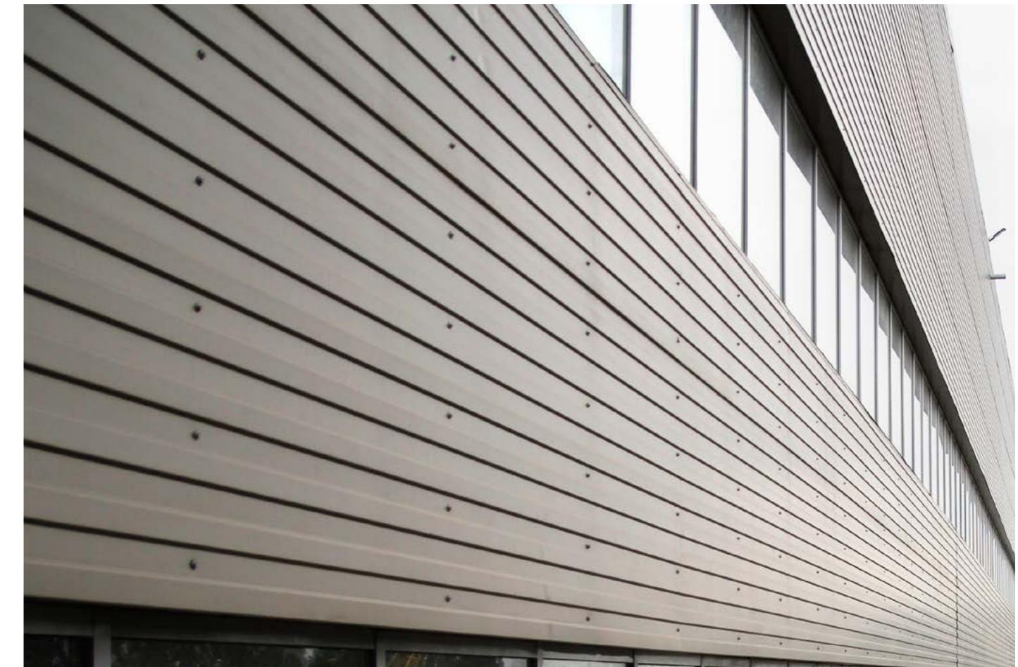
Надежность и долговечность соединений при монтаже строительных конструкций различного назначения достигается за счет применения специализированной фурнитуры. Одними из наиболее прогрессивных крепежных элементов на сегодняшний день являются строительные заклепки.
